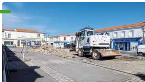
Débuts des travaux sur la Grand Place.
