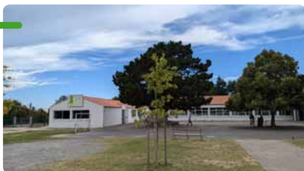
Groupe scolaire le Gois avant travaux.
